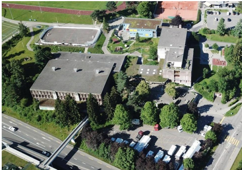
Bild: Bestehende Schulanlage auf dem Wettbewerbsareal
